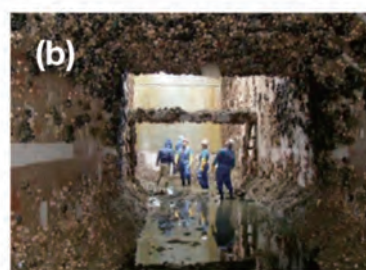
Fig.1 (a) フジツボ付着期幼生 (体長: 約500 \mu m) と着生した成体 (直径: 約15mm) (b) 発電施設の冷却水システムに付着したフジツボ群集
